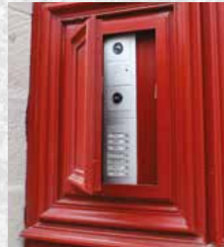
Interphone : un placard est inséré dans la porte pour y dissimuler l'interphone.
