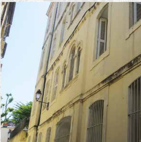
Ce bâtiment de style néoclassique était porté à être démolé, dans le PSMV de 1977. Aujourd'hui, sa qualité architecturale a été reconnue, il doit être conservé.
