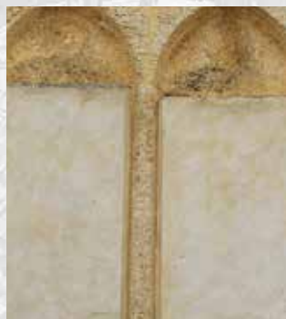
Traces de baies médiévales.
