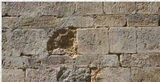
"Appareil de Montpellier" alternant pierres taillées, traversantes et posées sur chant, caractéristique de l'architecture montpelliéraine.
