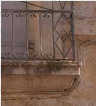
Réseaux : les câbles ont été retendus contre les moulures.
