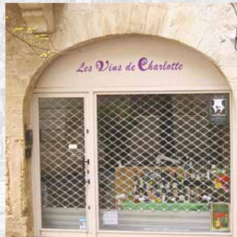
Le rideau de protection est placé à l'intérieur de l'établissement, derrière la vitrine.
