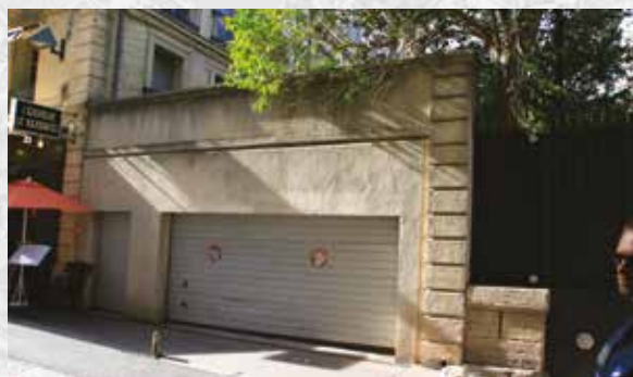
Garage porté à démolir.
